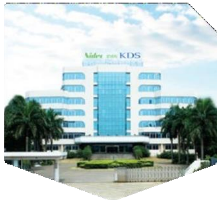
PLANTA KDS GUANG DONG, CHINA (1960) Elevadores
